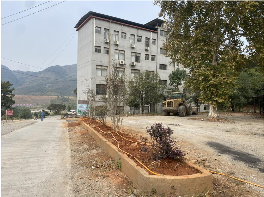
照片 5 新硬化道路两侧绿化沟照片（2022. 11）
