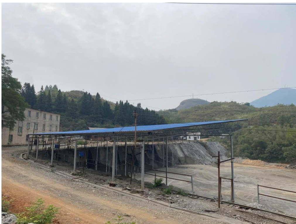
照片 9 1#矿石堆铁棚照片（2022.11）
