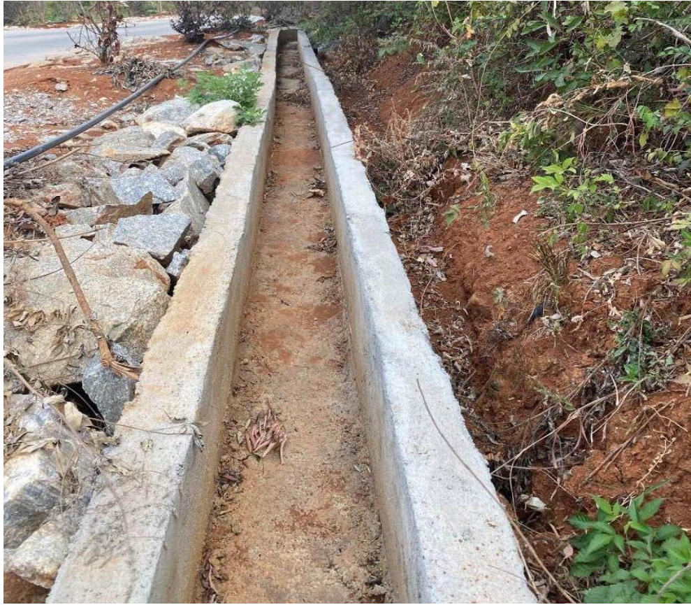
照片 7 新硬化道路排水沟照片（2022. 11）
