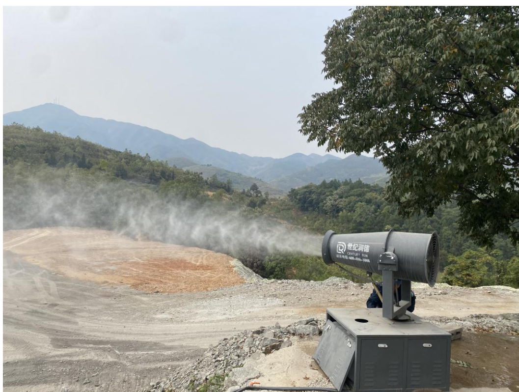
照片 10 1#矿石堆雾炮机照片（2022.11）
