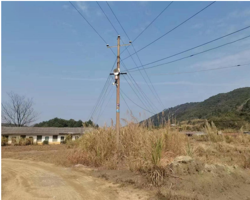
照片6 矿山进场道路现状
