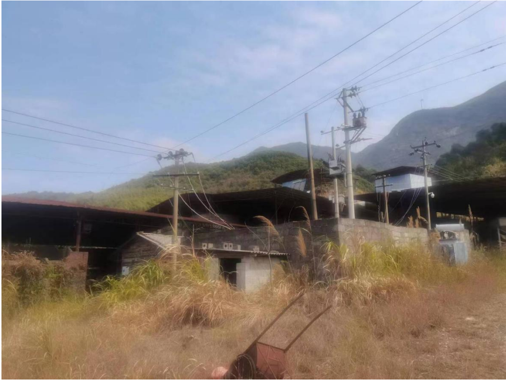
照片1 矿山加工区现状
