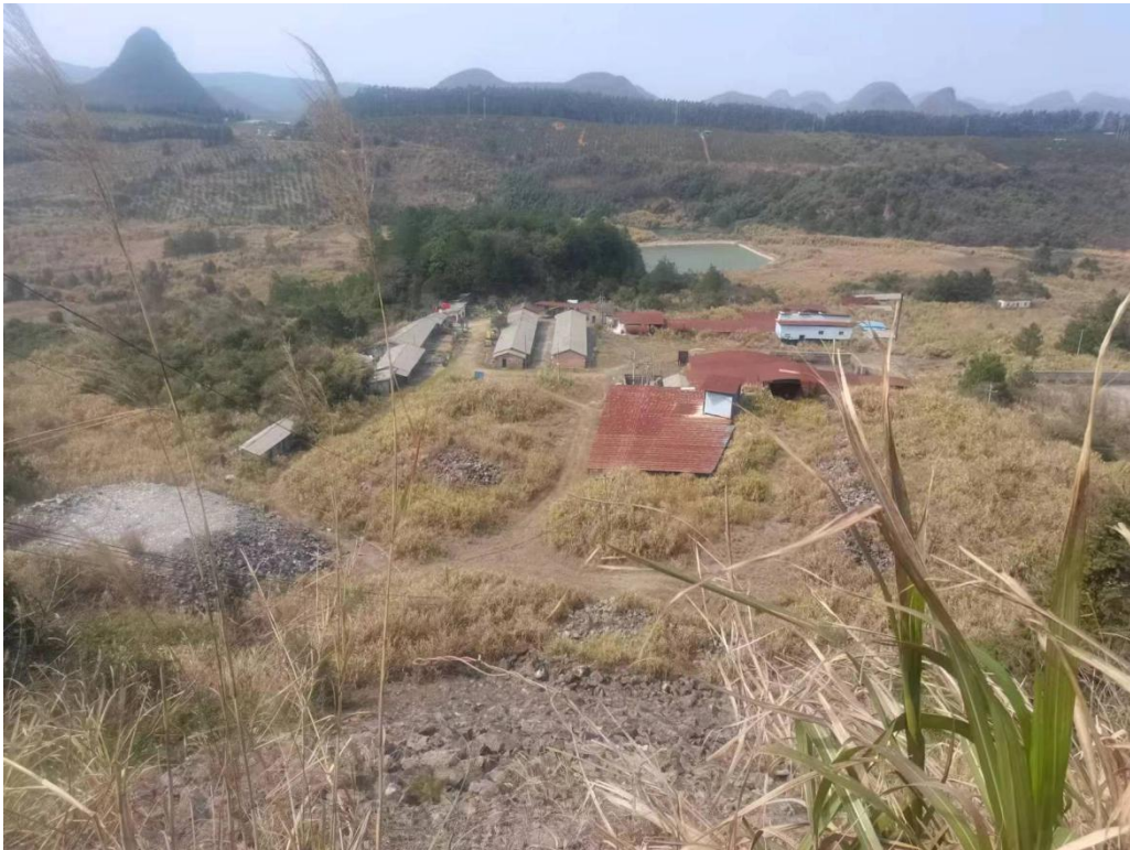
照片2 矿山工业广场现状
